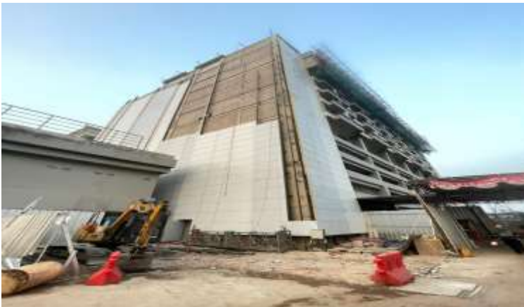
Pemasangan Pelapis Kulit Luar Sisi Barat Gedung Mess Parkir
