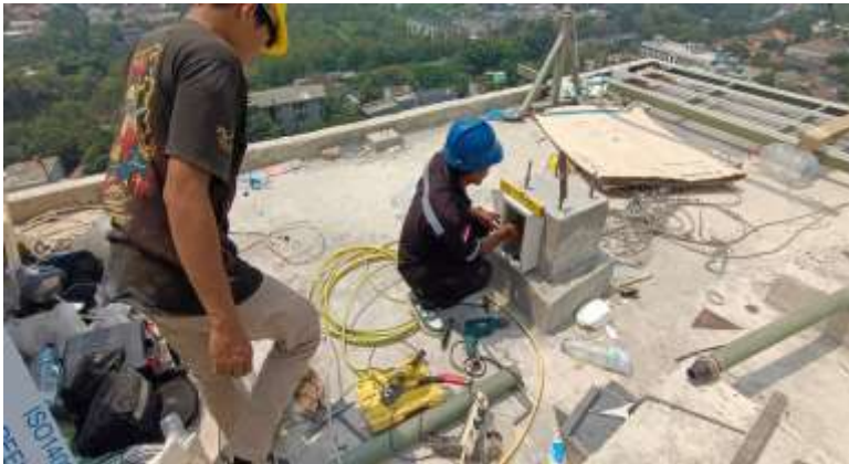
Pekerjaan Pemasangan Penangkal Petir
