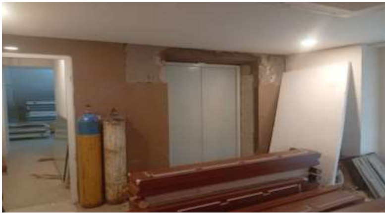
Pekerjaan Pemasangan Keramik Dinding Lobby Lift Lantai LG Sisi Barat
