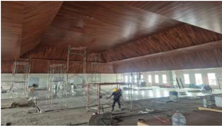
Pekerjaan Pemasangan Plafond Lambersering dan Keramik Lantai 8
