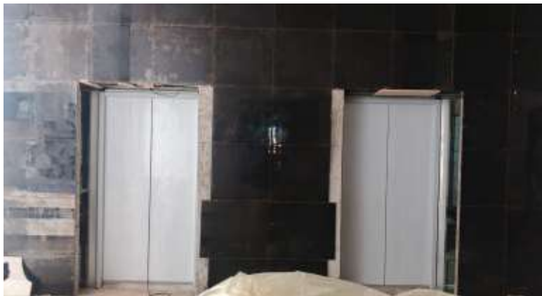
Pekerjaan Pemasangan Keramik Dinding Lift Penumpang Lantai 1 Rumah Duka
