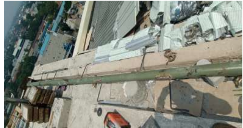
Fabrikasi Tiang Penangkal Petir
