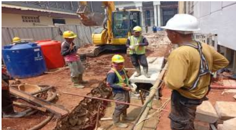
Pekerjaan Galian Box Culvert
