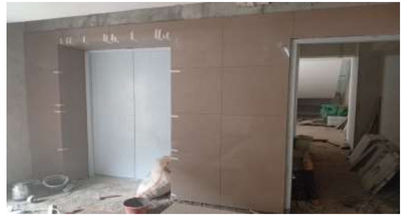
Pekerjaan Pemasangan Keramik Dinding Lobby Lift Lantai LG sisi Timur
