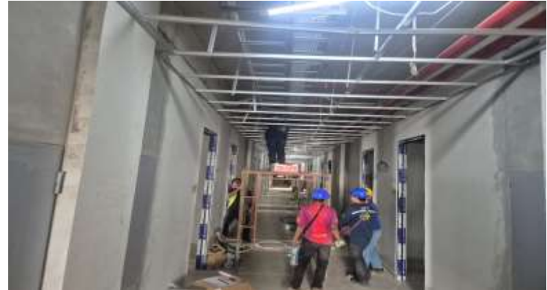
Pekerjaan Instalasi ME Lantai 6 Mess
