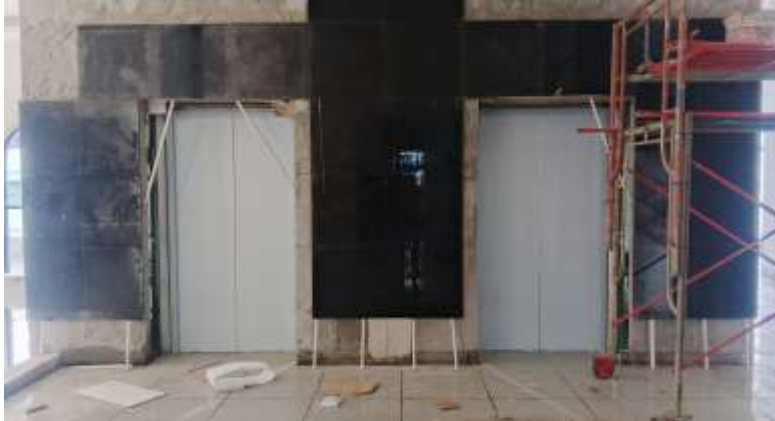
Pekerjaan Pemasangan Keramik Dinding Lift Lantai 2 Rumah Duka
