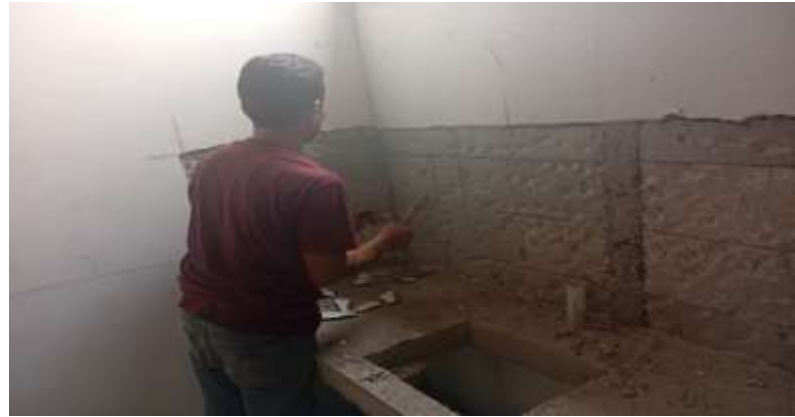
Pekerjaan Meja Kitchen Lantai 1 Rumah Duka
