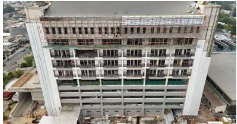
Kondisi Aktual Gd Mess Parkir dan Ruang Serbaguna Purehab Kemhan
