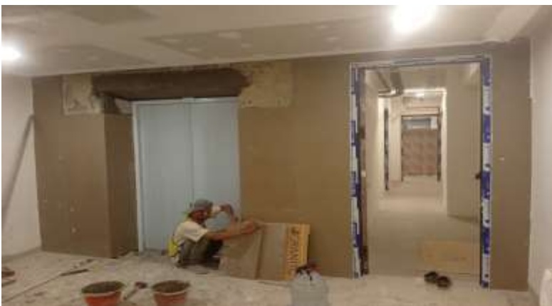
Pekerjaan Perapihan Lobby Lift Lantai 1B Sisi Barat
