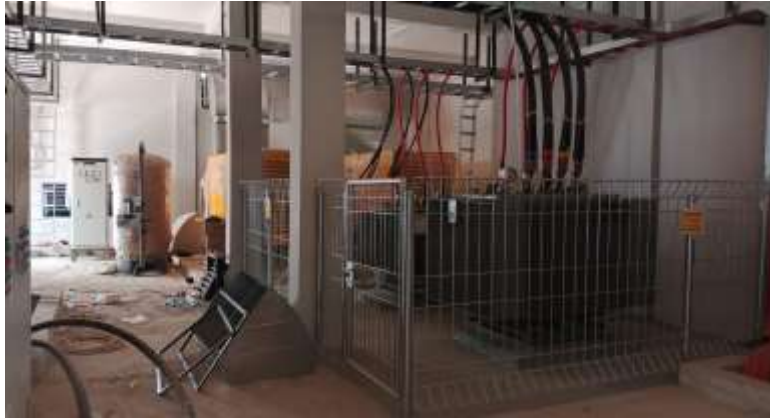
Kondisi dalam area Power House
