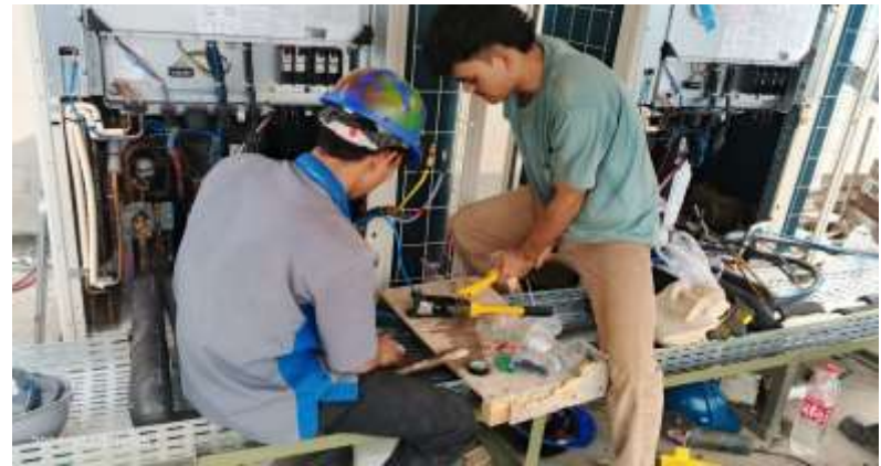
Pekerjaan Instalasi Outdoor AC
