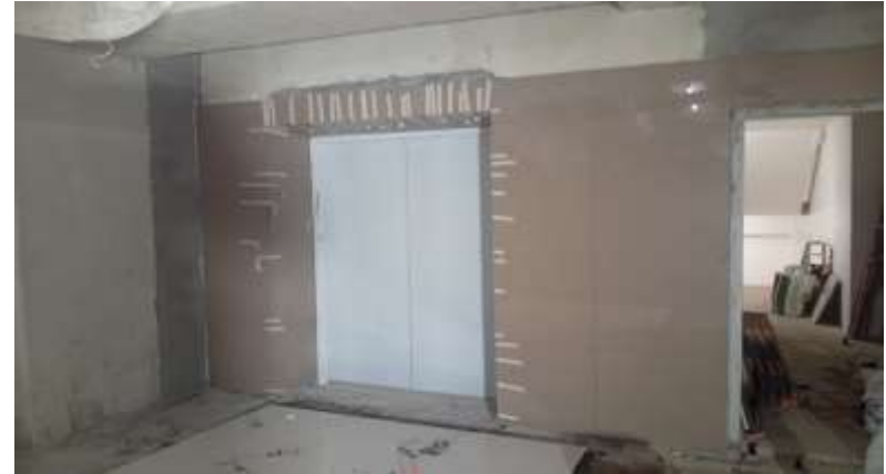
Pekerjaan Pemasangan Keramik Dinding Lobby Lift Lantai 1 Parkir sisi Timur
