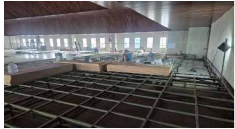
Pekerjaan Panggung Lantai 8
