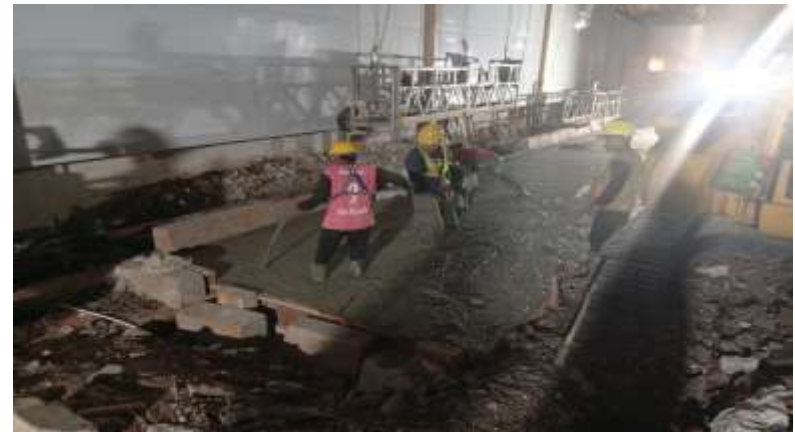
Pengecoran Hardstanding Damkar Sisi Timur
