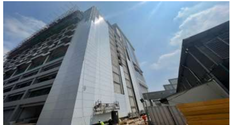
Pemasangan Pelapis Kulit Luar Sisi Timur Gedung Mess Parkir
