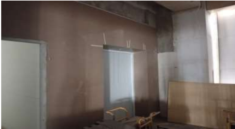
Pekerjaan Pemasangan Keramik Dinding Lobby Lift Lantai 4 Stemcell
