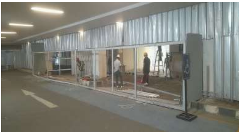
Pekerjaan Perapihan area Entrancee MCU
