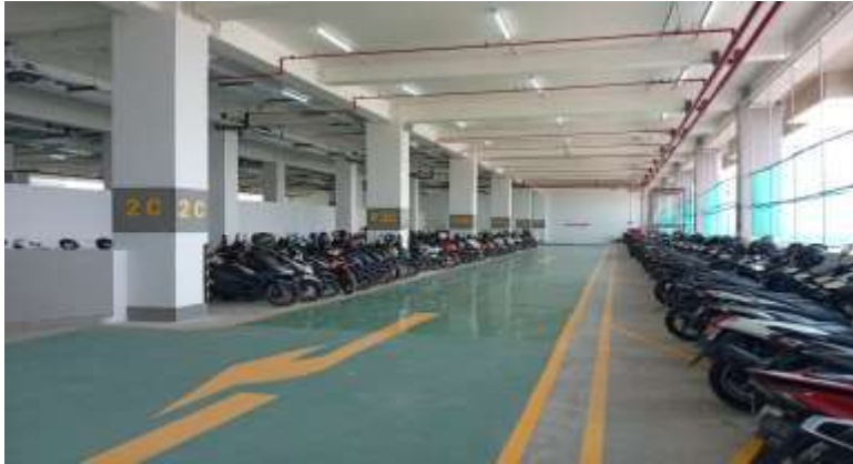
Kondisi Area Parkir Lantai 2C
