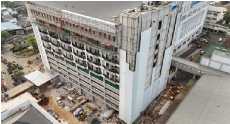
Kondisi Aktual Gd Mess Parkir dan Ruang Serbaguna Purehab Kemhan
