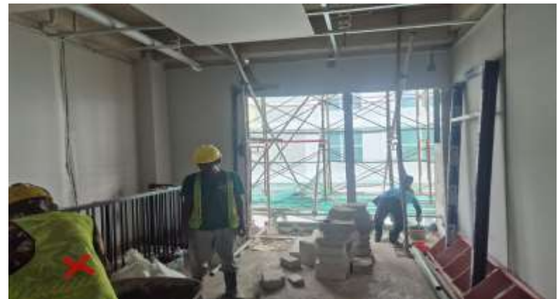
Pekerjaan Pemasangan Hebel Dinding Balkon Lantai 7 Mess
