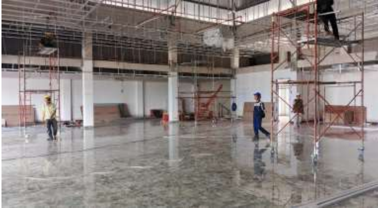
Pekerjaan Pemasangan Rangka Plafond Lantai 3 Rumah Duka
