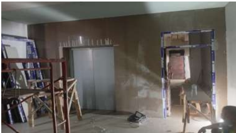
Pekerjaan Pemasangan Keramik Dinding area Lobby Lift Lantai 3 Parkir Sisi Barat
