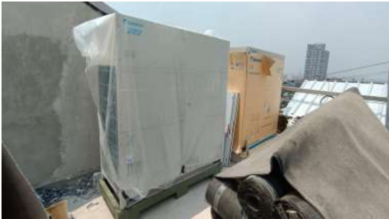
Penempatan Outdoor AC sisi Barat
