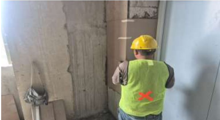
Pekerjaan Pemasangan Keramik Dinding Lobby Lift Lantai 6 Mess sisi Timur
