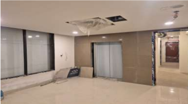
Pekerjaan Perapihan Lobby Lift Lantai 1 Parkir Sisi Barat
