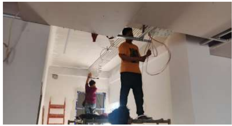
Pekerjaan Pemasangan Instalasi ME Lantai 3 Rumah Duka
