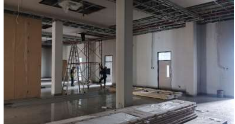
Pekerjaan Pemasangan Plafond Lantai 2 Rumah Duka
