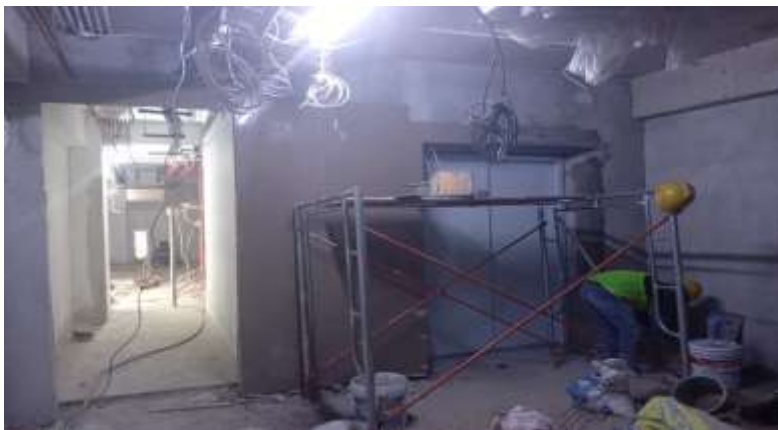
Pekerjaan Pemasangan Keramik Dinding Lobby Lift Lantai 2 Sisi Timur
