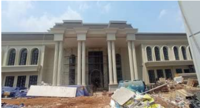
Pekerjaan Pasang Profil GRC Area Facade Lantai 1 Rumah Duka
