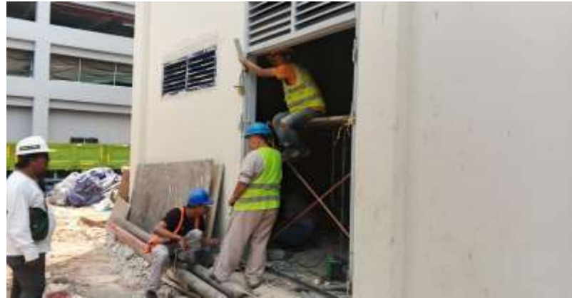
Pekerjaan Pemasangan Kusen Pintu Besi Power House
