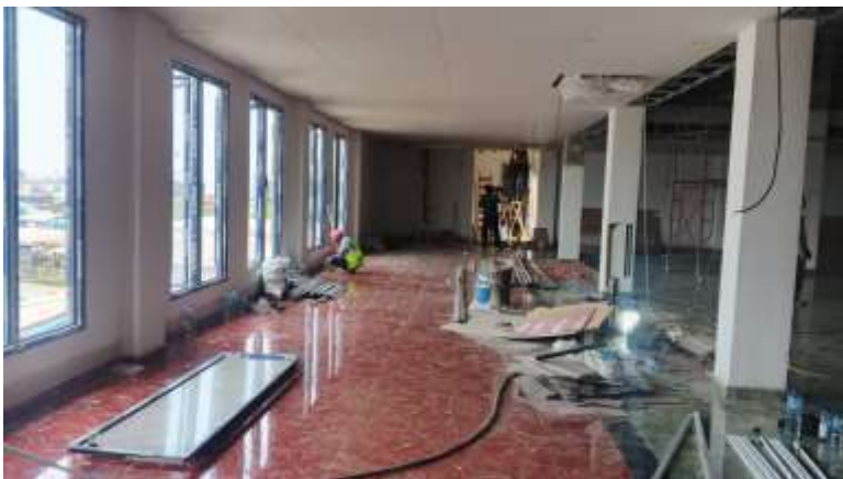
Pekerjaan Pemasangan Kaca Jendela Lantai 3 Rumah Duka
