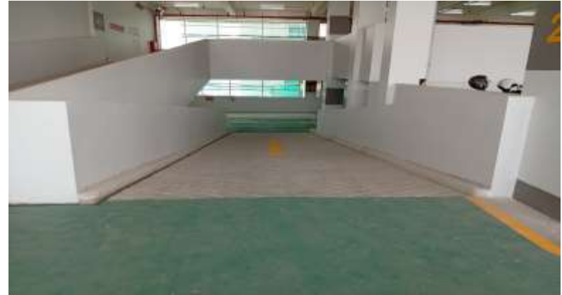
Kondisi Area Parkir Lantai 2C
