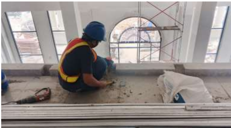
Pekerjaan Pemasangan Angkur Railing Selasar Lantai 2 Rumah Duka
