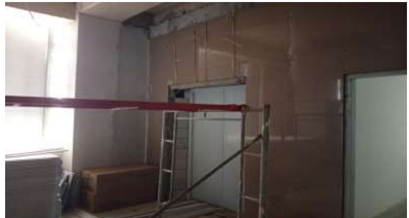
Pekerjaan Pemasangan Keramik Dinding Lobby Lift Lantai 5 Mess
