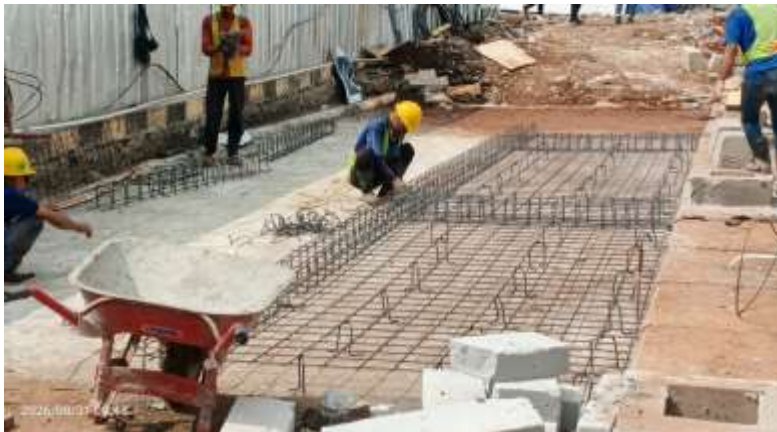
Pekerjaan Pembesian area Hardstanding sisi Timur
