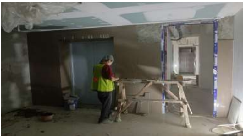
Pekerjaan Perapihan Lobby Lift Lantai 2B sisi Barat
