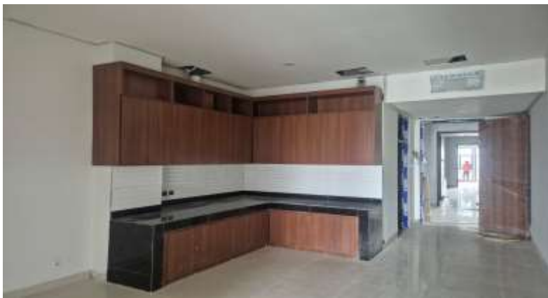
Pekerjaan Meja dan Kitchen Set Lantai 5 Mess
