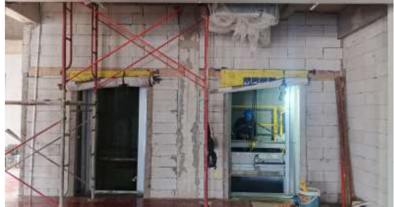
Pekerjaan Pemasangan Dinding Lift Lantai 3 Rumah Duka
