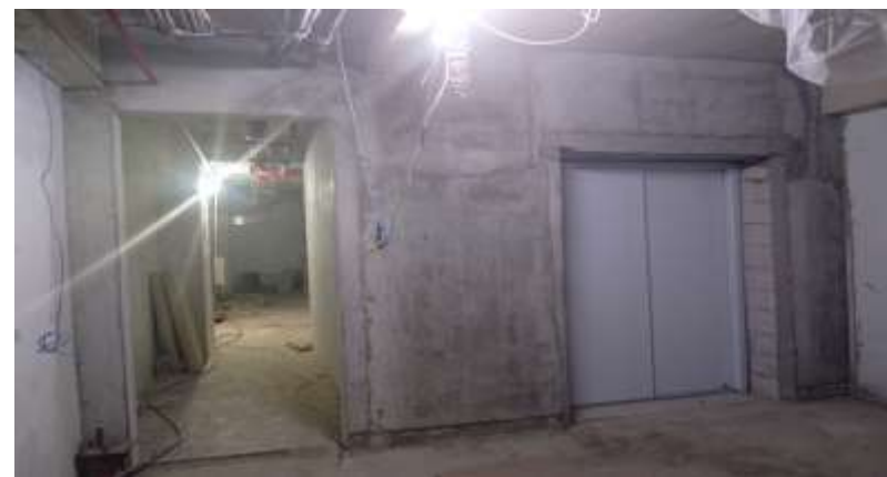
Pemasangan Plester Dinding Lobby Lift Lantai 1B Sisi Timur
