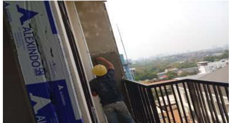
Pekerjaan Plester Aci Dinding Lantai 4 Stemcell
